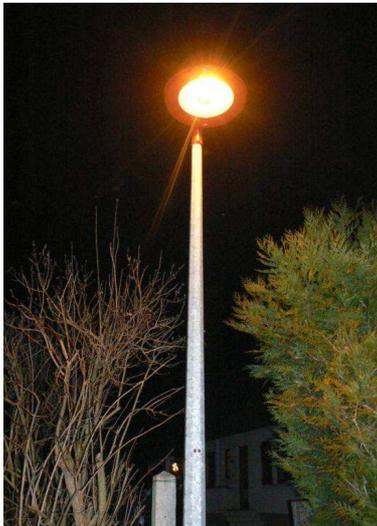
L'entreprise Huber Electricité a procédé au **remplacement de 24 luminaires** situés rue des Vergers, rue Martin Drolling, rue Principale et rue de Biltzheim. Les anciens luminaires ballon fluo à vapeur de mercure de 125W ont été remplacés par des lampes à vapeur de sodium haute pression (dits SHP) de 50-70W permettant une division par deux de la consommation électrique. Cette solution encouragée par l'ADEME est subventionnée à hauteur de 8 640 €.
